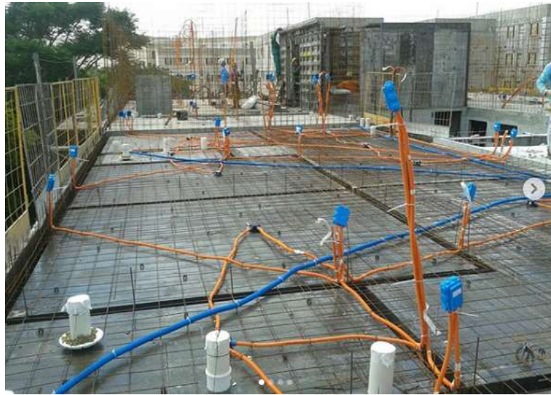
Figura 24 – Módulos das instalações na obra Solar dos Pássaros, da MRV, Salto-SP
